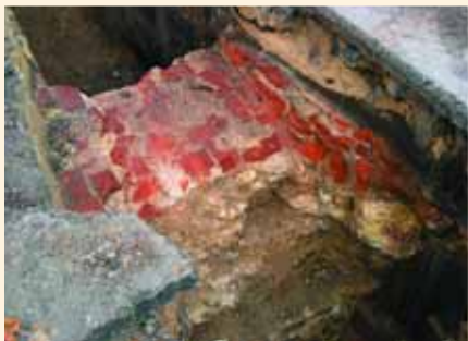
Фрагмент фундамента трапезной части Покровского храма, вскрытый при прокладке газопровода. Фото 2003 г.
