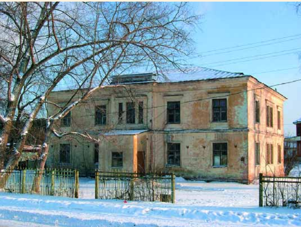
Здание бывшего егерского училища в пос. Тракторного завода г. Липецка. Фото 2003 г.
